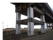
大規模地震対策（新幹線高架橋柱）
