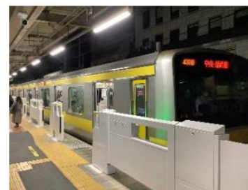
ホームドア整備
