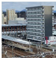
学生マンションの建設
