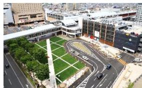
秋田駅西口駅前広場整備
