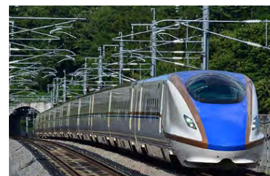
新幹線自動運転実証試験
