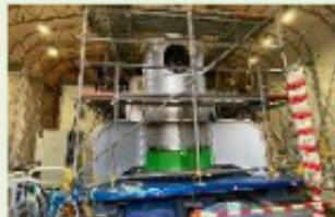
鉄道用超電導フライホイール蓄電システムの実証実験
