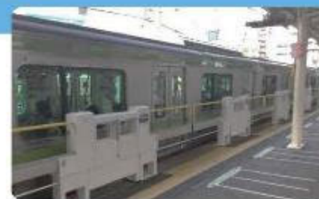
ホームドア整備
