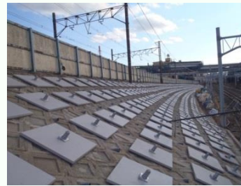
耐震補強対策
