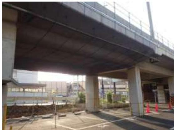
高架橋等落下物対策
