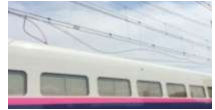
東北新幹線郡山駅構内架線切断
