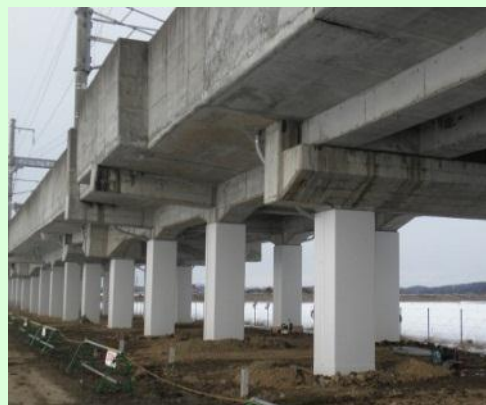
高架橋柱耐震補強
