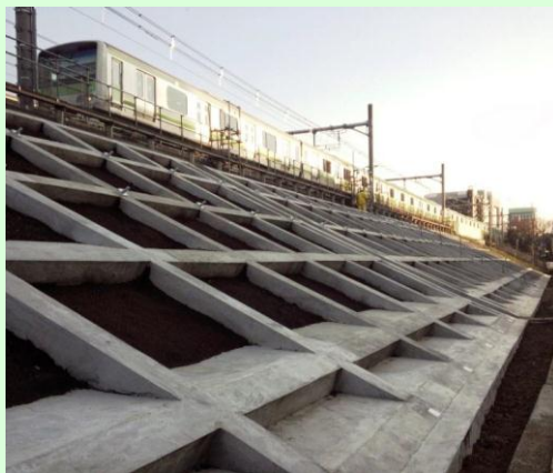
盛土耐震補強
