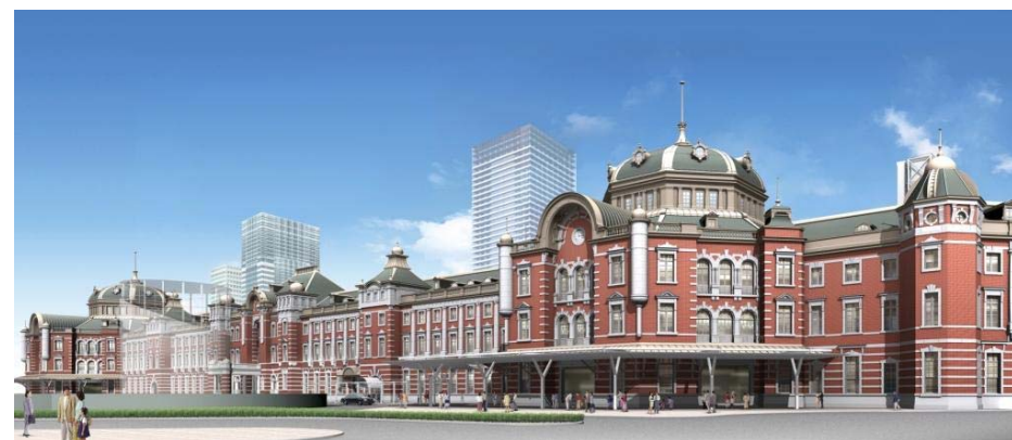
東京駅丸の内駅舎保存・復原
