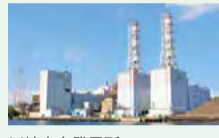
川崎火力発電所 Kawasaki Thermal Power Plant
