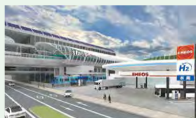
水素ステーション Integrated hydrogen station
