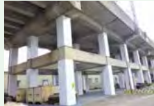
【高架橋柱 (新幹線)】 [Viaduct columns (Shinkansen)]
