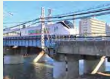
【橋脚 (在来線)】 [Bridge piers (Conventional lines)]
