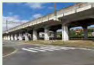
【高架橋柱 (在来線)】 [Viaduct columns (Conventional lines)]
