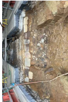
トレンチ④ 検出状況(東から) 石垣1段と裏込め石を検出
