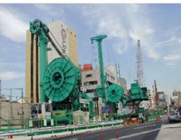
RC連壁 施工状況
