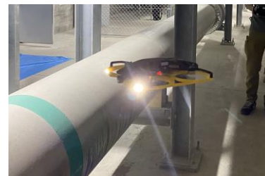
ドローンを活用した設備点検
