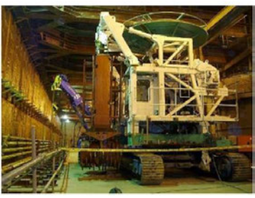
路下鋼製連壁 施工状況
