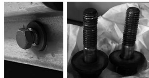
図18 ボルト固着時の状況と取り外したボルト
