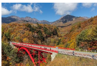
北杜市 東沢大橋
