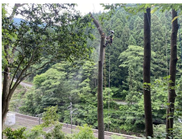
沿線樹木伐採の様子
