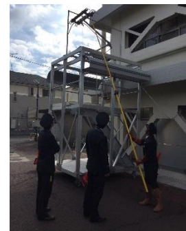
パンタグラフ除雪訓練の様子
