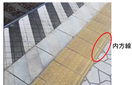
内方線付き点状ブロック
