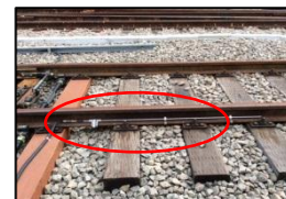
①に加え、レール腹部についている板が温まるヒーターを設置
