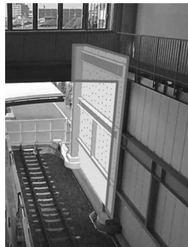
図8 部材の重なり状況
