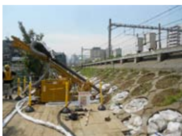
盛土の補強例及び補強イメージ
