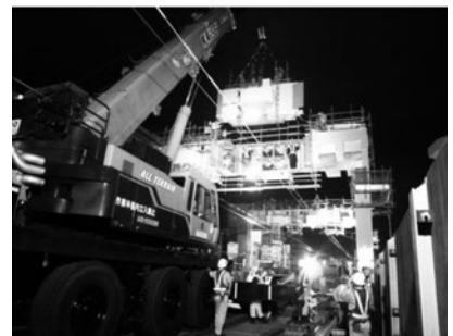
写真2 100tクレーンによる鉄骨部材架設
