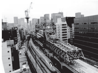
(b) 移動式架設機全景
