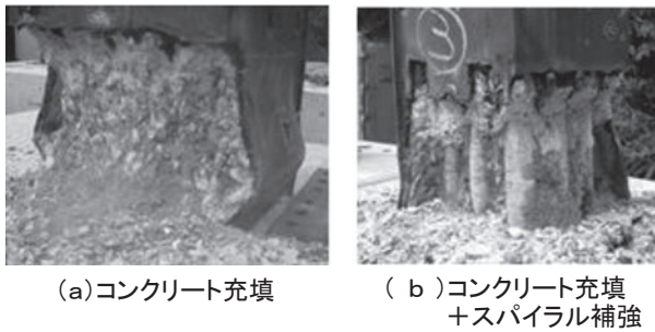
図6 実験終了後鋼管内部状況(柱基部)
