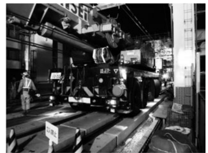
写真1 RC製線路覆工板と100tクレーンの移動
