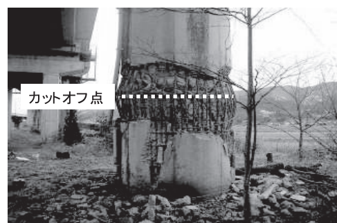
図1 地震時橋脚く体中間部カットオフ点損傷例
