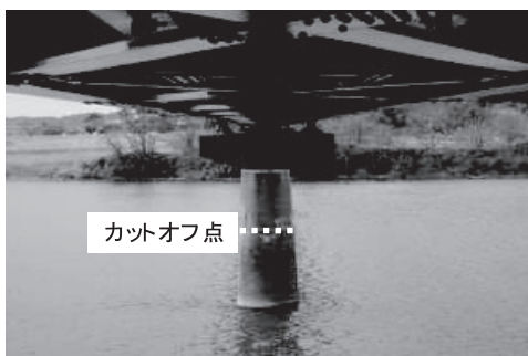
図1 地震時橋脚く体中間部カットオフ点損傷例
