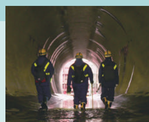
トンネル内点検
