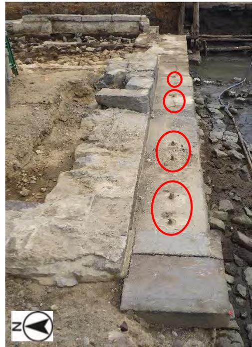
図2-3-62：拡幅後の北側橋台上面で確認された笠石（手前）と石積上面に残るアンカーボルト（赤丸箇所）
