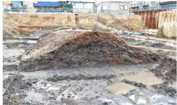
図2-3-29：蒲鉾形に盛土された築堤の芯
