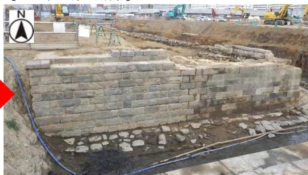
図2-3-59：発見当初の第7橋梁橋台北側橋台（左）と乗り越し橋解体後の橋台（右）
