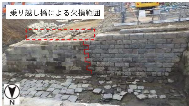
図2-3-58：橋台拡幅の痕跡
