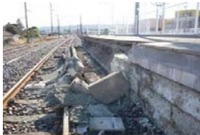
コ.【ホーム擁壁倒壊(常磐線 常陸多賀駅) 復旧前
