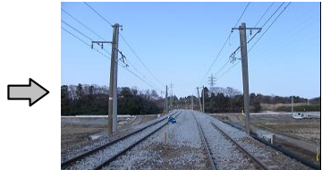
ケ.【盛土沈下(常磐線 水戸～勝田間) 復旧前
