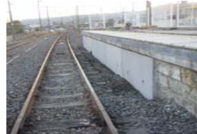
コ.【ホーム擁壁倒壊(常磐線 常陸多賀駅) 復旧前
