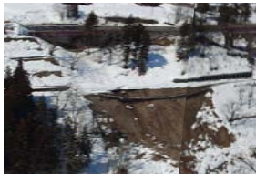
ス.【盛土流失(飯山線 横倉～森宮野原間) 復旧前
