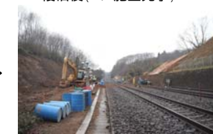
復旧後(4/1施工完了)
