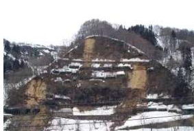
シ.【切取崩壊(飯山線 足滝～越後田中間) 復旧前
