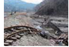
E【線路流失】 ほそら (大船渡線 細浦構内)
