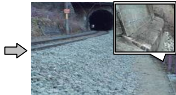
キ.【土留壁傾斜・道床流失(奥羽本線 庭坂～赤岩間) 復旧前
