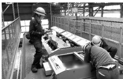
図3 定期自主検査の実施（屋根上配管ユニットに対する外観検査）
