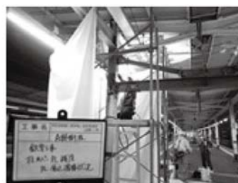
図2 溶接作業の火花対策
