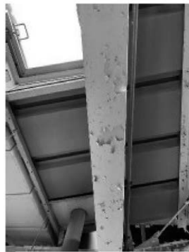
図29 塗膜の浮き
