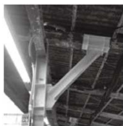
図1 方杖補強の例
