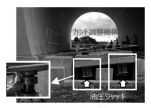
図8 トンネルスラブの可変装置
