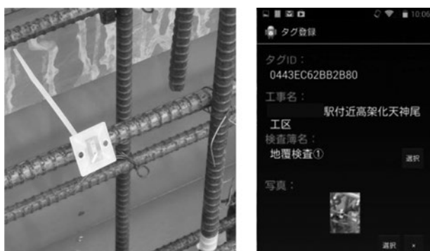
図5 構造物管理用ICタグと認証時のツールの画面
