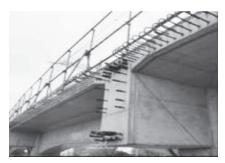
図1 施工継目部例
