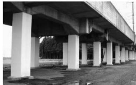
図17 高架橋の耐震補強
