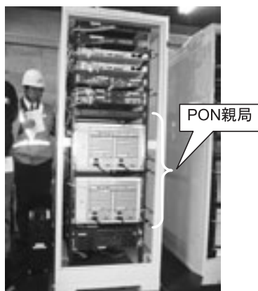
図7 ネットワーク機器架
