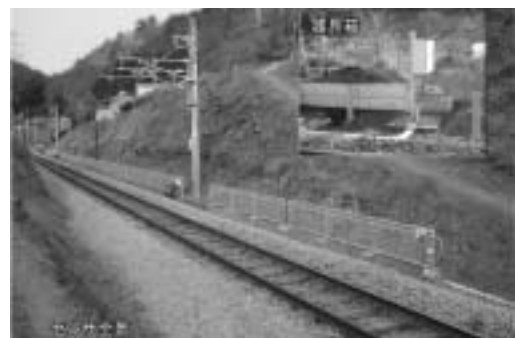
図26：設置状況（切取）
