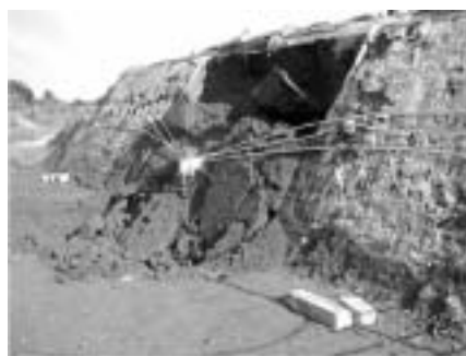
図11：盛土崩壊実験の状況
