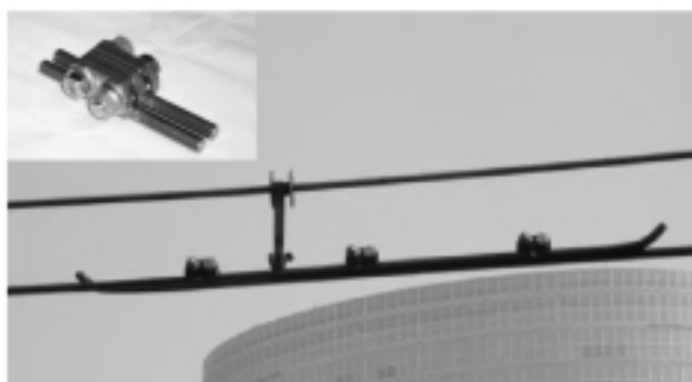
図1：Wイヤー接続方式(左上はWイヤー金具単体)
