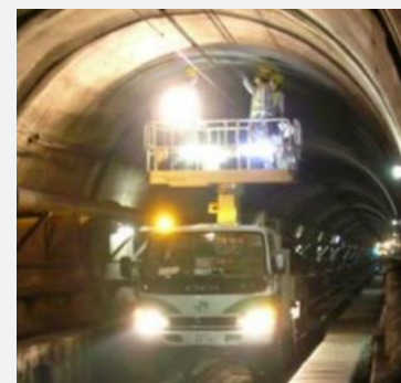
土木構造物の検査・修繕
