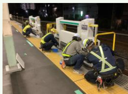
ホームドア工事
