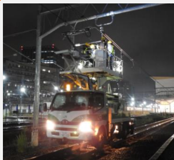
電力設備の点検・修繕
