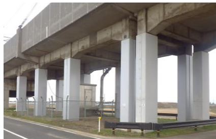
高架橋柱耐震補強
