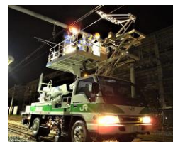
架線設備の検査
