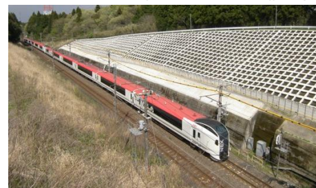
切取り面工（吹付枠工）
