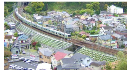
盛土のり面工（吹付砕工）
