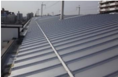
屋根飛散・落下防止対策（金属屋根）
