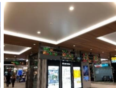
照明設備のLED化
