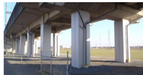
大規模地震対策（新幹線高架橋柱）
