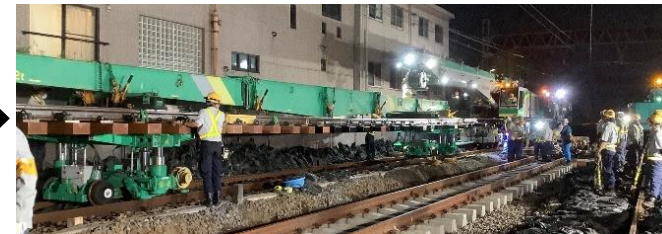
大型機械作業
