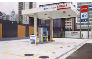
水素ステーション
