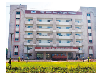
建設中のインド高速鉄道研修センター宿泊棟
