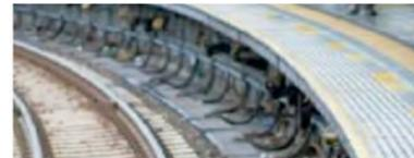
ホーム下に設置したマットで転落者を検知し、列車に停止を指示します。
