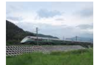
盛土のり面工(吹付砕工)
