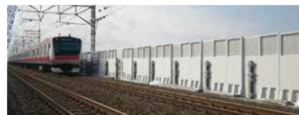
京葉線 潮見～新木場間
