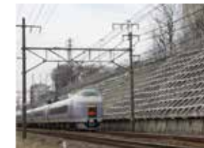
切取のり面工(吹付砕工)
