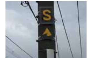
津波注意区間の始端標
