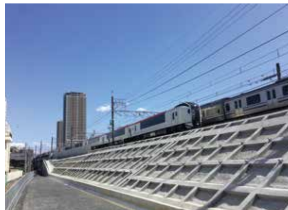
盛土耐震補強
