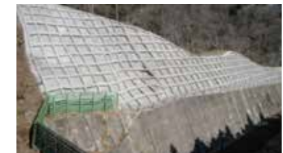
自然斜面防護工(吹付砕工)
