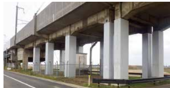
耐震補強対策
