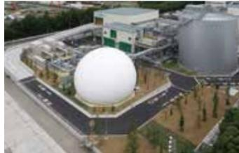
2018年8月に完成した横浜工場では、JR東日本グループのほか食品メーカー等から一日あたり最大80tの食品廃棄物を受け入れ、メタン発酵処理で発生するバイオガスを利用して、発電を行っています。最大で一般家庭約3,000世帯分の発電量となり、そのほか排熱の一部を工場内で有効活用します。
