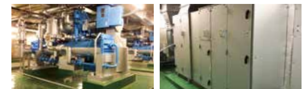
設備更新後の高効率ターボ冷凍機と空調機
