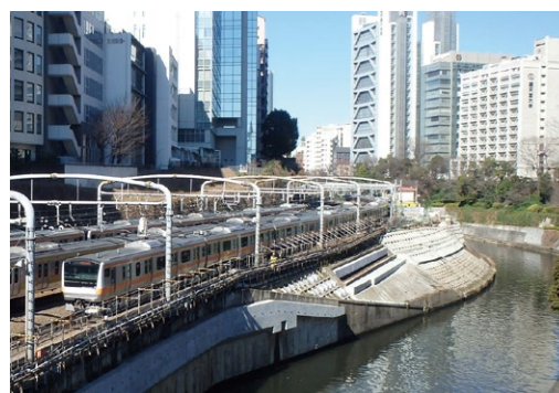
盛土耐震補強
