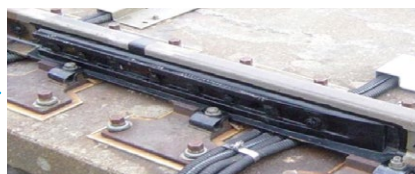
改良後の接着絶縁継目
