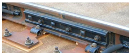
改良前の接着絶縁継目
