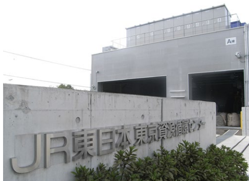
JR東日本東京資源循環センター
