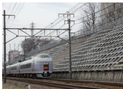
切取のり面工（吹付砕工）
