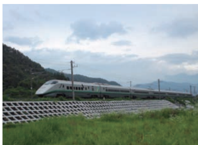
盛土のり面工（吹付砕工）
