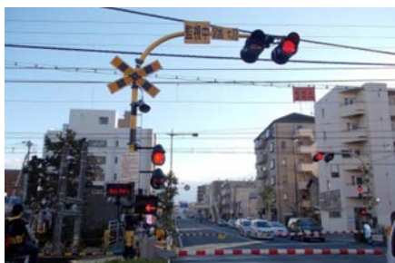
警報機を道路の上方に設置。
