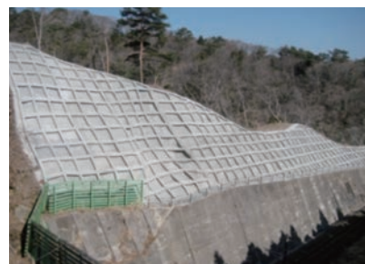
自然斜面防護工（吹付砕工）
