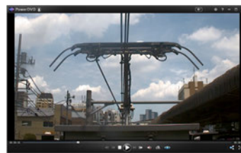
電力設備モニタリング装置で撮影された実際の画像 (管轄の各技術センターで閲覧可能)
