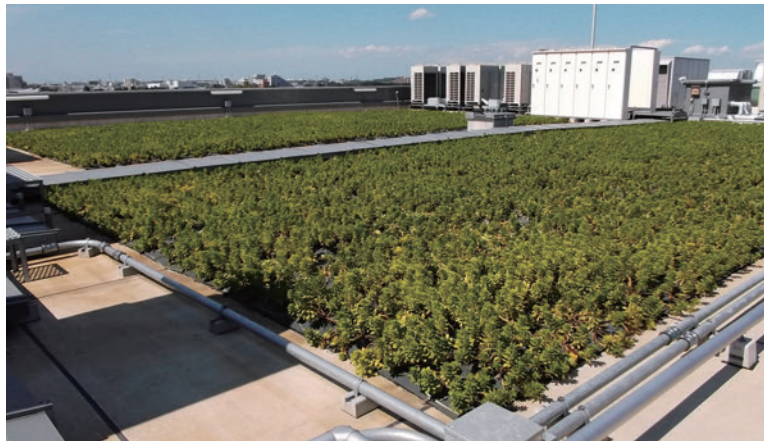
千葉支社ビルの屋上緑化
