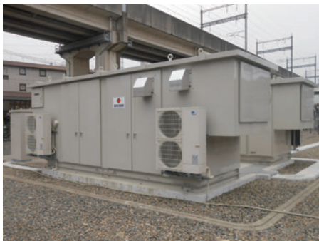
久喜変電所電力貯蔵装置
