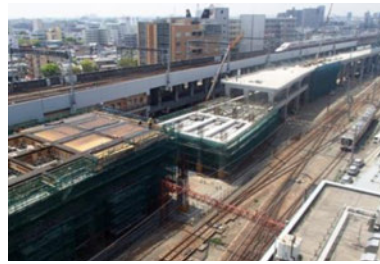
信越本線新潟駅付近高架化
