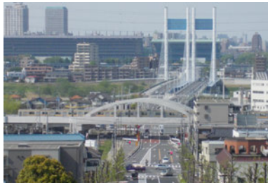
南武線稲城長沼駅付近高架化
