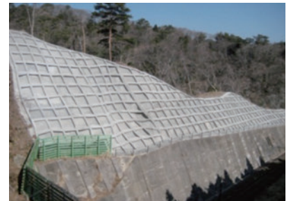
自然斜面防護工 (吹付砕工)
