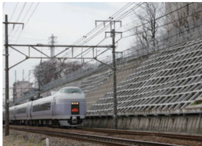
切取り面工 (吹付砕工)
