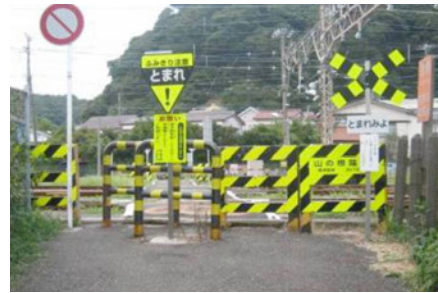
自動車通行禁止の踏切に「交通規制柵」を設置。
