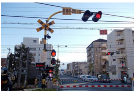
警報機を道路の上方に設置。
