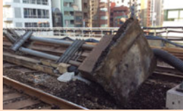
2015年4月12日 山手線神田～秋葉原間での 電化柱倒壊（重大インシデント）
