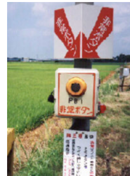
踏切支障報知装置
