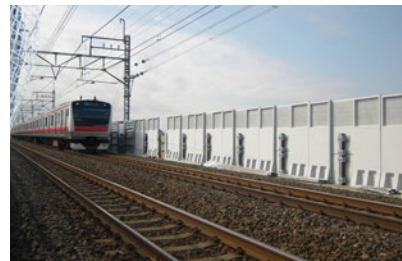
京葉線 潮見～新木場間
