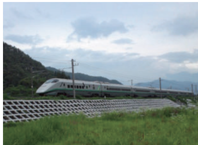
盛土のり面工 (吹付砕工)
